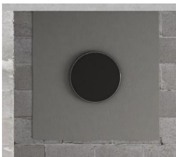
5.3pav. Ortakio įrengimas kai ortakio skersmuo \varnothing \leq 400\text{mm}
