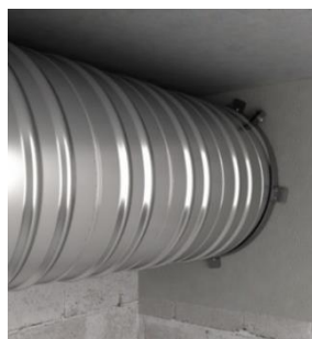
5.4pav. Ortakio įrengimas kai ortakio skersmuo \varnothing > 400\text{mm}
